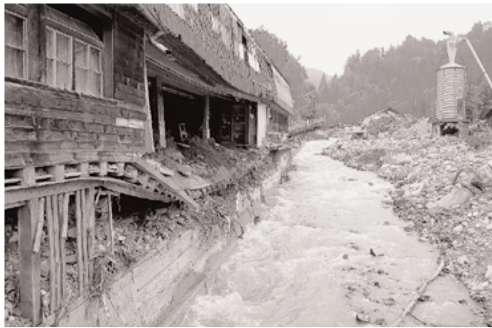
Vom Hochwasser zerstört: Das Sägereiwerk Bettchen in Kien.
