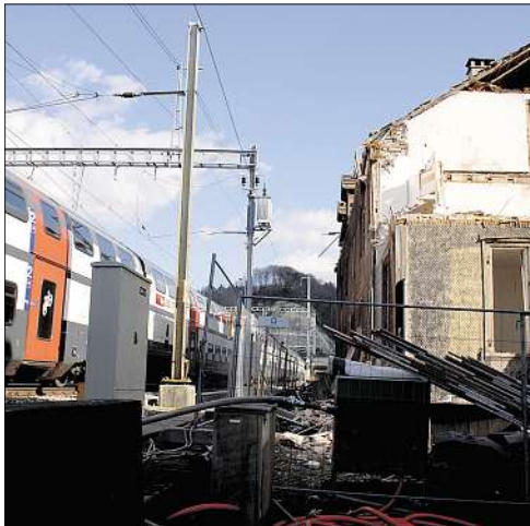
Gefährlich nahe rauscht der Zug auf den Geleisen der Olten – Bern Strecke am Haus an der Poststrasse vorbei, das seit letztem Mittwoch abgerissen wird. Nicole Siegrist
