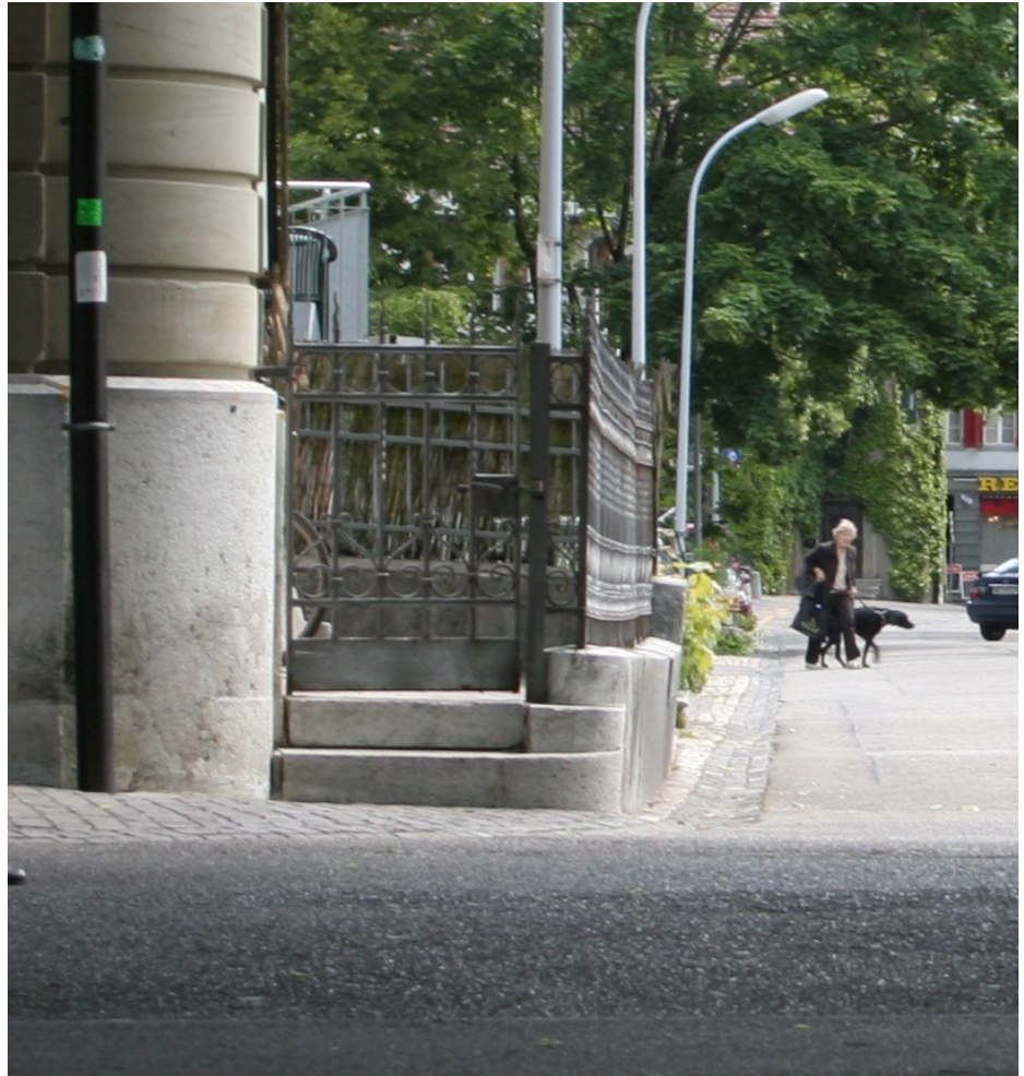
Abbildung: Die Gestaltungsbaulinie liegt auf der heutigen Parzellengrenze - Entwässerungsrinne und Randstein bilden den Abschluss des öffentlichen Bereichs
